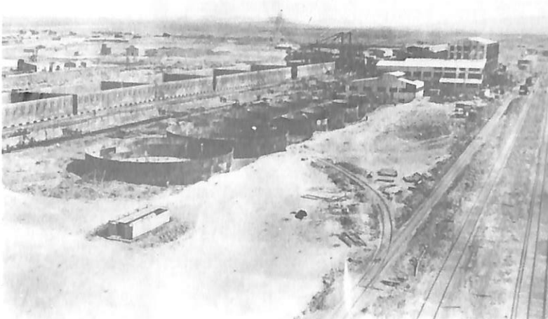
Parte de la construcción, junio 1926, de la Oficina María Elena (ex Coya Norte).
