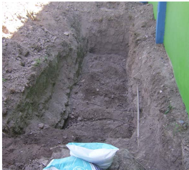
Figura 3: Instalación de malla a tierra tipo.
